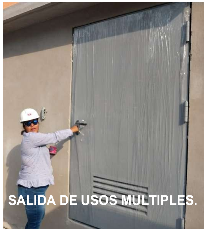
SALIDA DE SERVICIO UL60-180 MIN.
